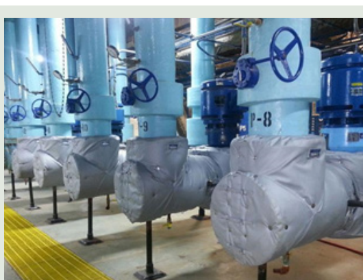
Slika 30. Odvojiva izolacija na cirkulacijskim pumpama [56]
