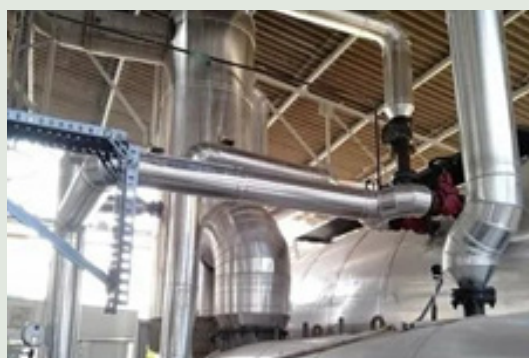
Slika 26. Fiksna izolacija cijevi [51]
