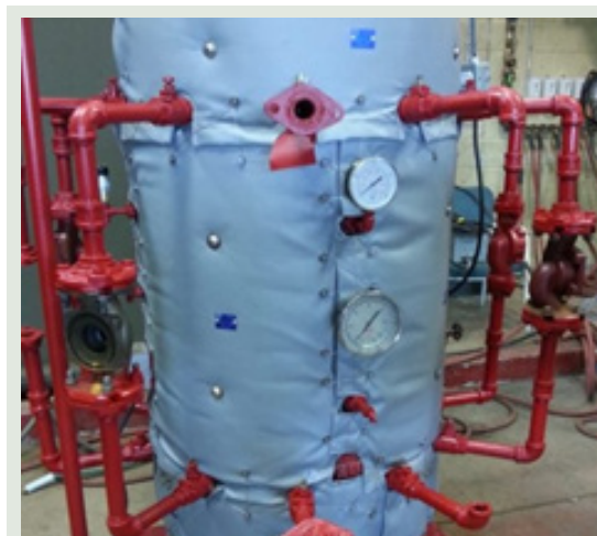
Slika 21. Odvojiva izolacija od kompozitnih materijala [46]
