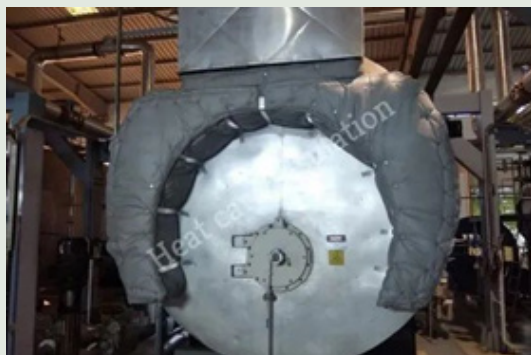
Slika 23. Odvojiva izolacija cilindričnog kotla [48]
